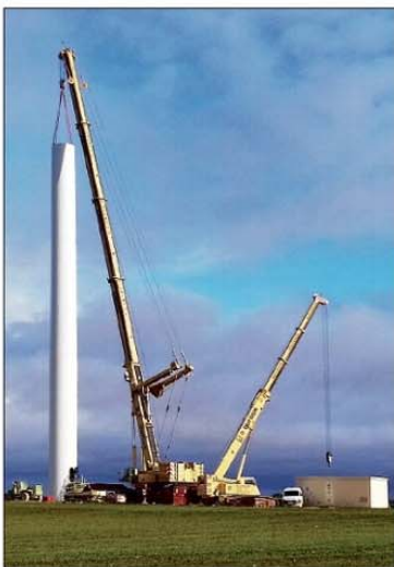
Des sites sont en voie d'achèvement, comme à Arville, vers Puisseux. Des projets se dessinent en silence du côté de Treilles, avec des éoliennes de près de 200 m de haut.
