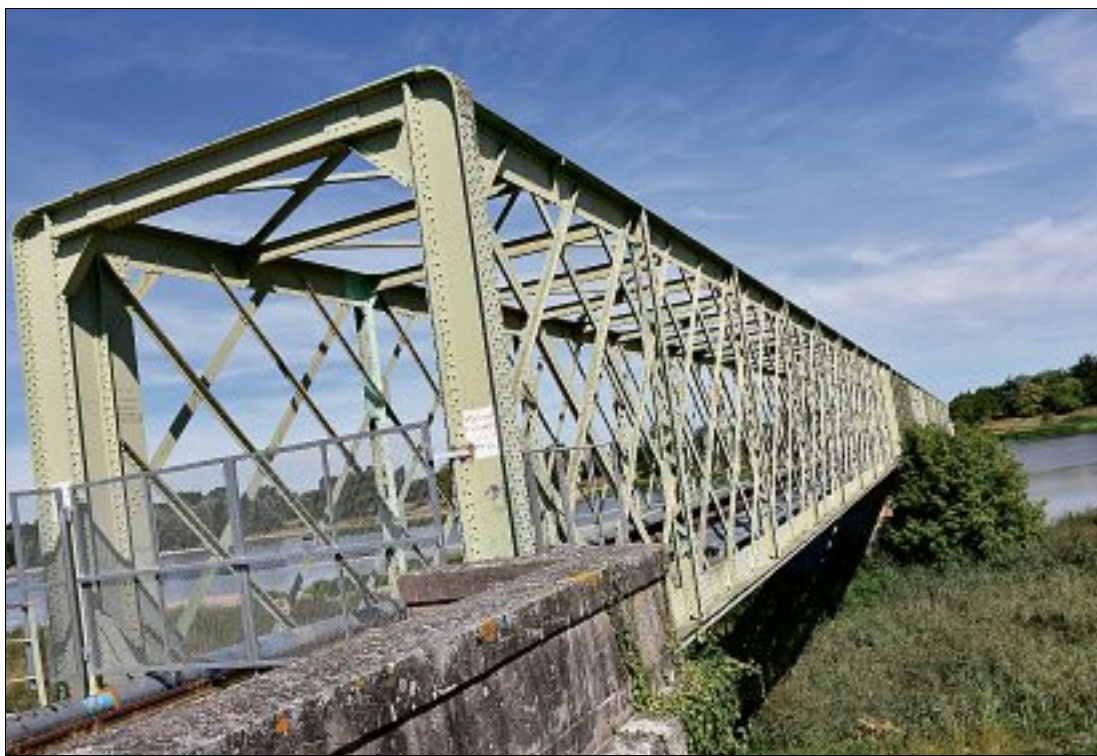
SÉCURITÉ. Le pont de chemin de fer reliant Sully à Saint-Père-sur-Loire deviendrait une voie douce pour les piétons et les cyclistes. Jusqu'à maintenant, ils traversent le pont routier, situé en amont, dangereux. PHOTOS ANNE-LAURE LE JAN
