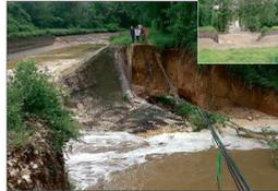
LA DIGUE CÈRE. Le point de rupture de la digue du canal à la sortie de Montargis. En médiation pendant les inondations, puis ci-dessus quelques jours après.
