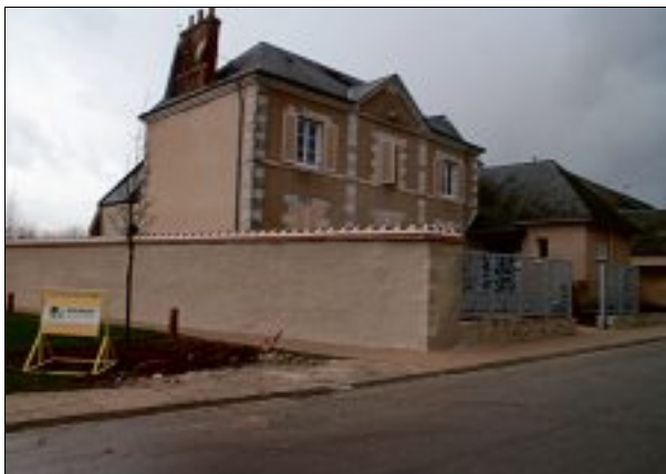
TRAVAUX. L'accessibilité aux personnes handicapées a été réalisée devant la salle des fêtes.
