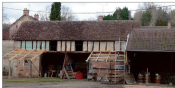
Les maisons Giffon sont actuellement en travaux.
