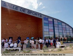
À Fay-aux-Loges, ce grand et beau bâtiment a été l'objet de critiques, pour les insufflations.
