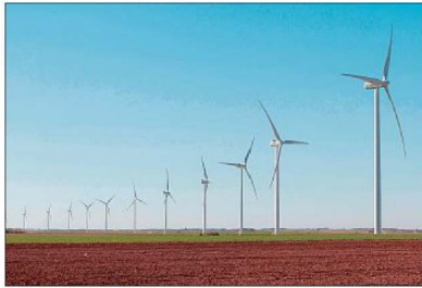
Sept éoliennes pourraient être implantées par la société Nordex à Varenes et Oussoy.
