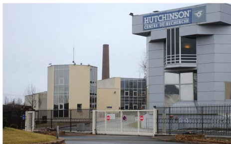
Un centre technique d'innovation a été construit récemment sur le site historique de Châlette-sur-Loing (Loire). CHRISTELLE BESEVRE/PHOTOPOR/PUBLIQUE DU COUTUMIER
